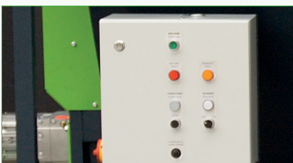
Schaltschrank mit Frequenzumrichter zur Geschwindigkeitsregulierung
